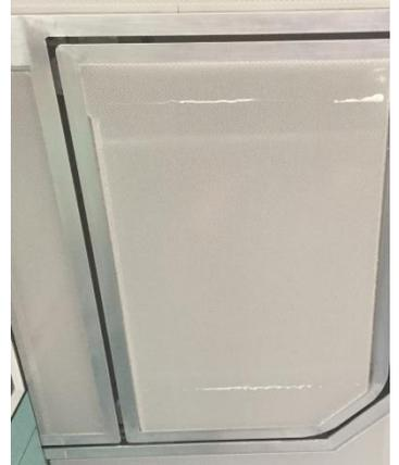
**Montage:** Die leichten aber trotzdem stabilen ClearPerf® Paneele werden in eine Tragkonstruktion aus transparentem Kunststoff eingelegt. Die kurzen Seiten werden stumpf zusammen gestossen und Längsseiten überfälzt verlegt.
